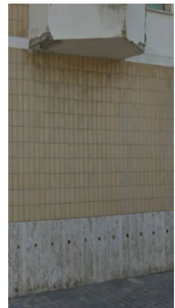
DETTAGLIO FINITURA FACCIATA
