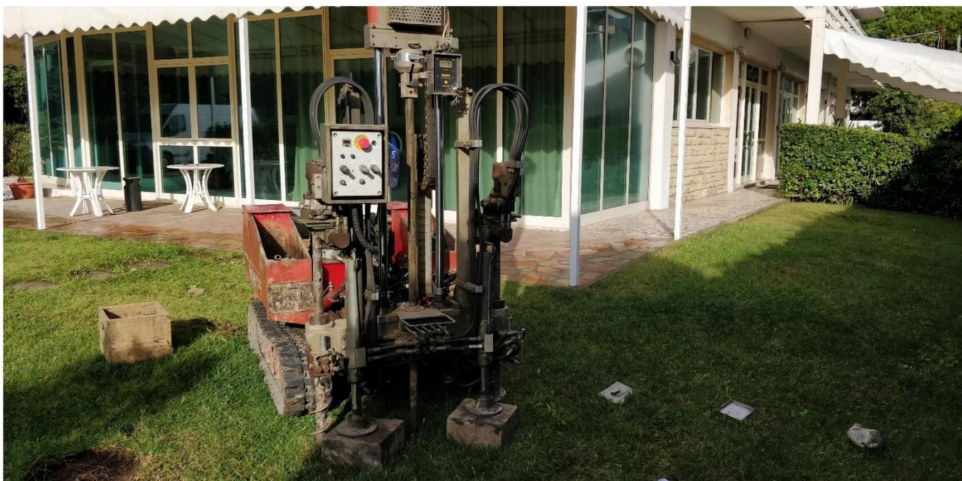
**Figura 6** INDAGINE PENETROMETRICA CPT2 ESEGUITA SUL SITO
