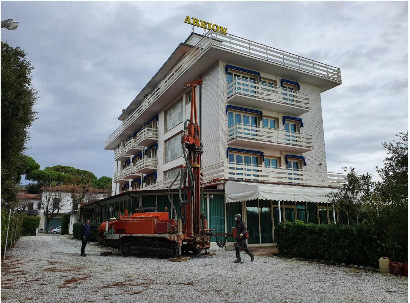
**Figura 3 SONDAGGIO A CAROTTAGGIO CONTINUO ESEGUITO SUL SITO**
